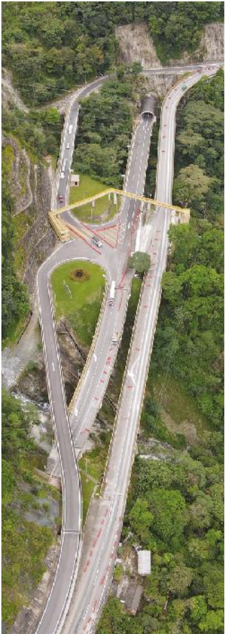
Túnel chirajara-fundadores via bogotá - Villavicencio
