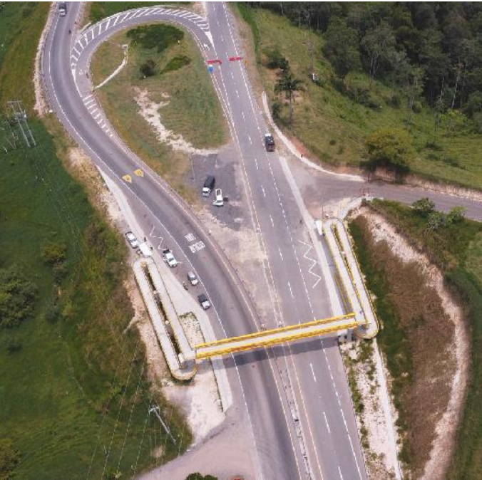
Segunda calzada via Bucaramanga - Barrancabermeja- Yondó
