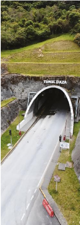
Túnel Daza, vía Pasto – Chachagüí
